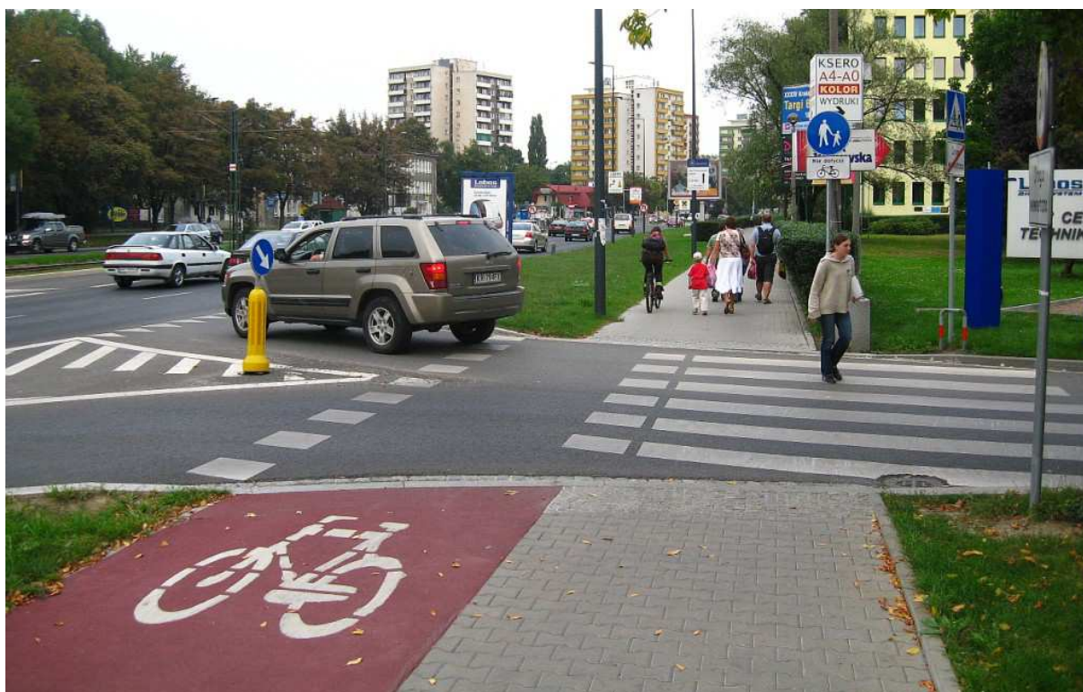
Rysunek 4. Kraków: rozwiązanie tymczasowe dla zapewnienia ciągłości trasy rowerowej. Fot. Marcin Hyła.
