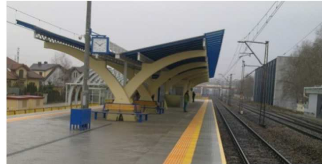
Fot. 1 Widok na peron
