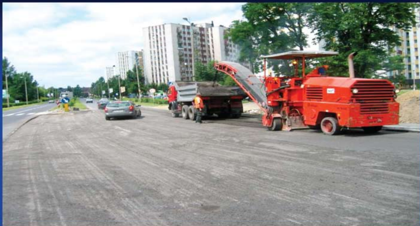
Frezowanie zniszczonej nawierzchni asfaltobetonowej
