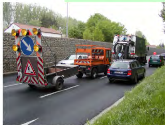
Verkehrssicherung während der Reinigung
