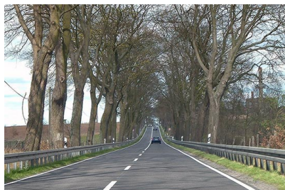
Fot. 6. Bariery energochłonne oddzielające drzewa od jezdni na jednej z dróg w Niemczech
