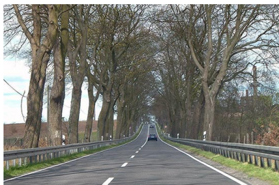
Fot. 6. Bariery energochłonne oddzielające drzewa od jezdni na jednej z dróg w Niemczech
