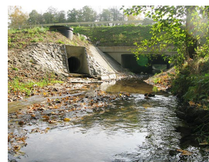
Fot. 3. Przejście dla zwierząt
