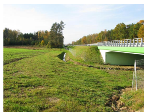
Fot. 2. Przejście dla zwierząt
