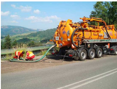
Fot. 37 - 42. Czyszczenie urządzeń ochrony środowiska
