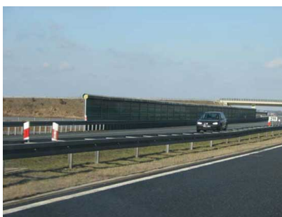
Fot. 18. Przykład typowego zastosowania ekranu akustycznego na autostradzie A4 (Polska)
