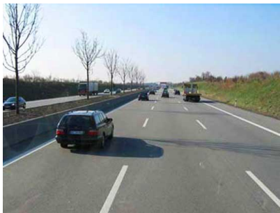
Fot. 5. Wykorzystanie ekranujących własności wykopu na autostradzie oraz elementów pasa dzielącego (Niemcy)
