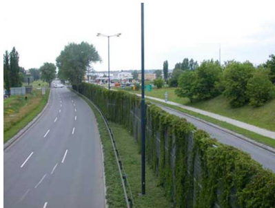
Fot. 20. Przykład wału ziemnego (po lewej stronie drogi) oraz ekranu akustycznego w postaci ściany w pasie dzielącym (Polska-Kraków)
