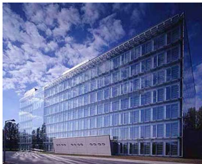
Fot. 24. Budynek LOT w Warszawie (autor projektu: S. Kuryłowicz z zespołem - źródło: www.apaka.com.pl )
