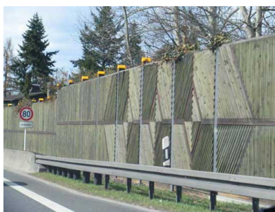
Fot. 14. Przykład lokalnego ograniczenia prędkości do 80 km/h przy użyciu znaku drogowego, którego celem jest ograniczenie poziomu hałasu w otoczeniu drogi (Niemcy)
