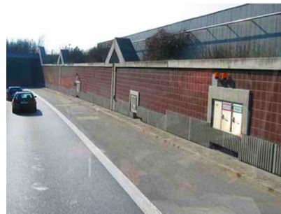
Fot. 6a. Wlot do tunelu (Niemcy)
