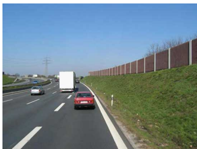
Fot. 21. Przykład kombinacji ekranu ziemnego z ekranem akustycznym (Niemcy)
