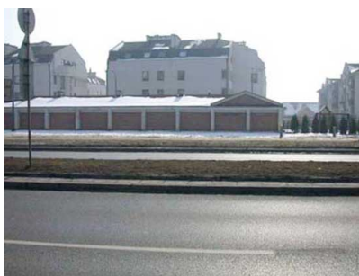
Fot. 22. Przykład kombinacji ekranu ziemnego z ekranem akustycznym (Niemcy)
