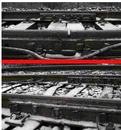
Fot. 8. Tor po wymianie drewnianych podkładów na stalowe o specjalnym „Y” kształcie i zastosowaniu szyn bezстыkowych (Polska - wg projektu Zespołu badawczego prof. W. Czyżczyły - Politechnika Krakowska)
