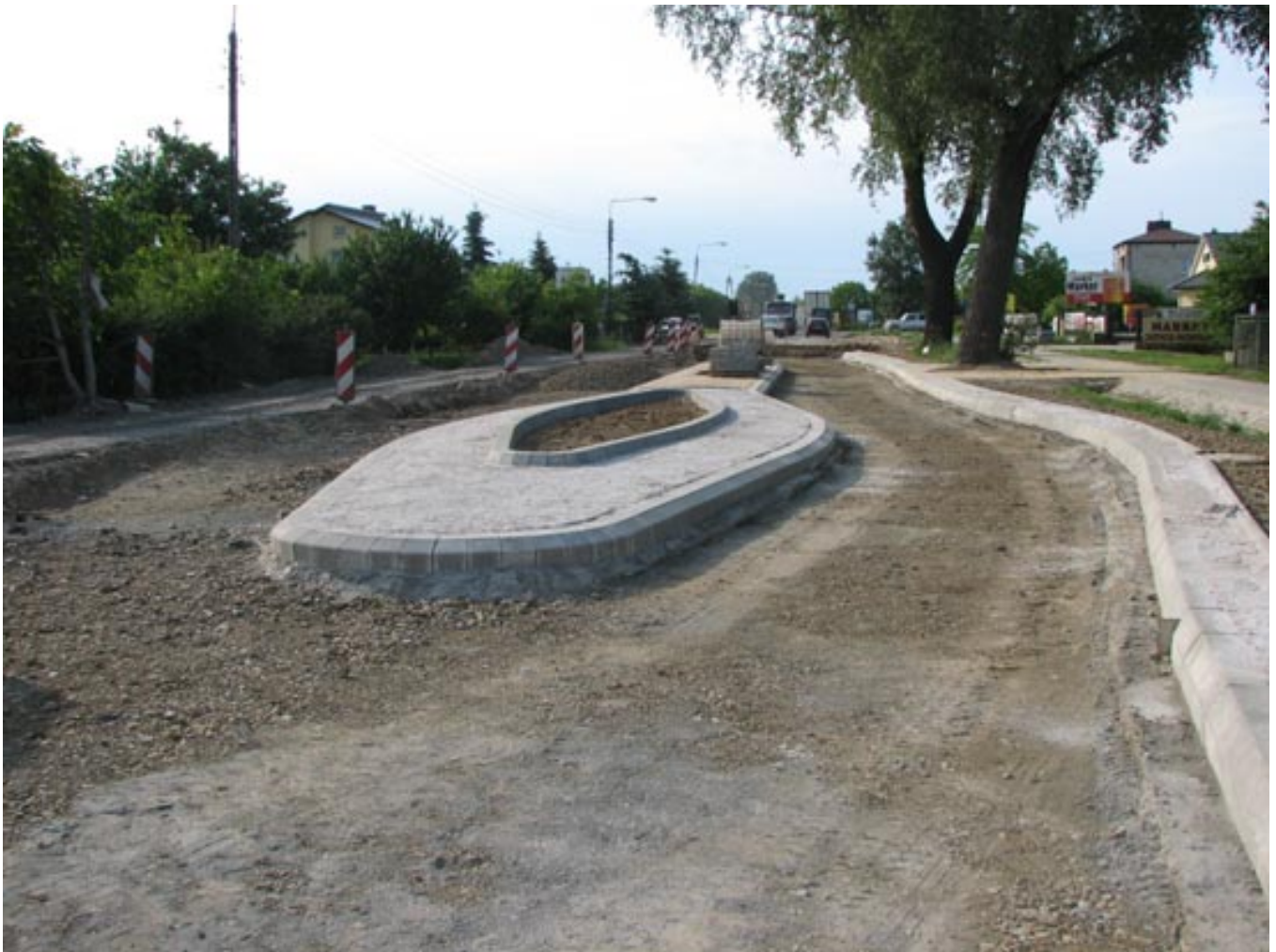
Fot. 4. Brama wjazdowa do miejscowości (w trakcie jej wykonywania)
